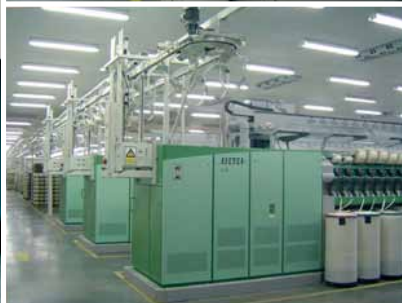
► INSTALACIONES AUTOMÁTICAS DE TRANSPORTE DE CONOS
